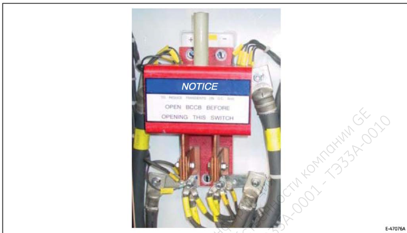
Рис. 26. Переключатель аккумулятора (BS).
