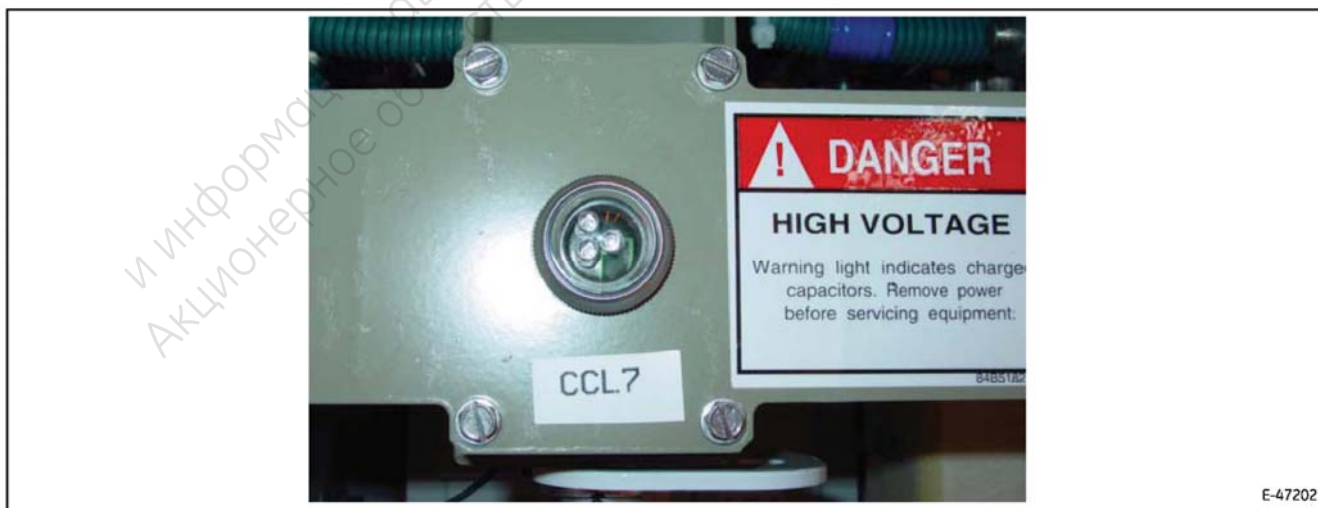
Рис. 25. Индикатор заряда конденсаторов (CCL).
