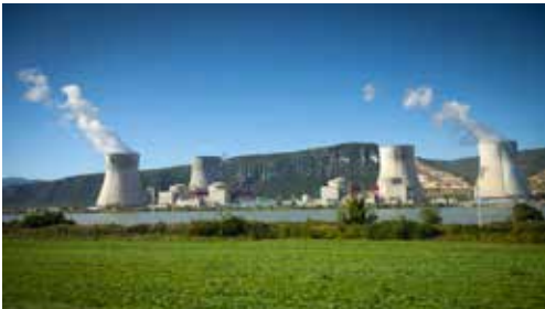
Мал. 43. Атомна електростанція в Мозелі (Франція)
