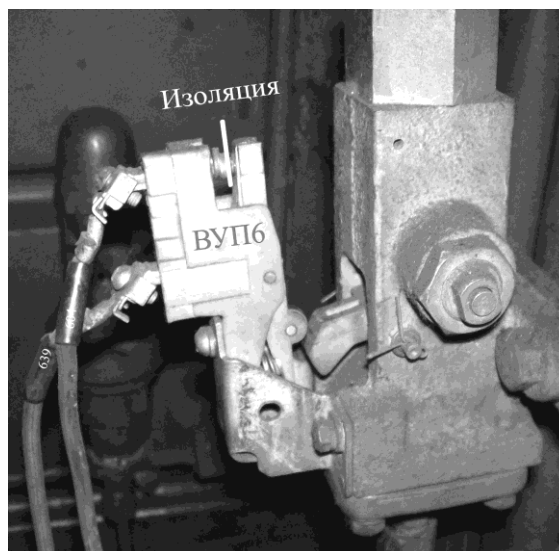
Рис. 311. ВУП6 – прокладывание изоляции блок-контактов
