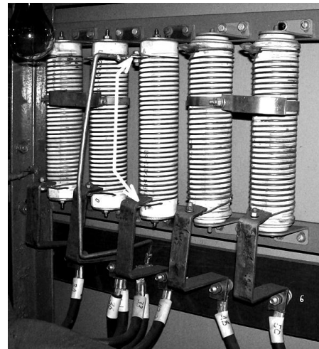
Рис. 281. Соединение сопротивлений для шунтирования контакта контактора К1
